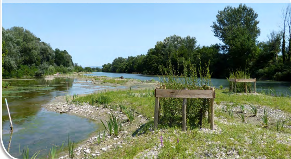
Aménagement sur un bras mort du Rhône, combinant apport de matériaux, génie végétal et plantations.
