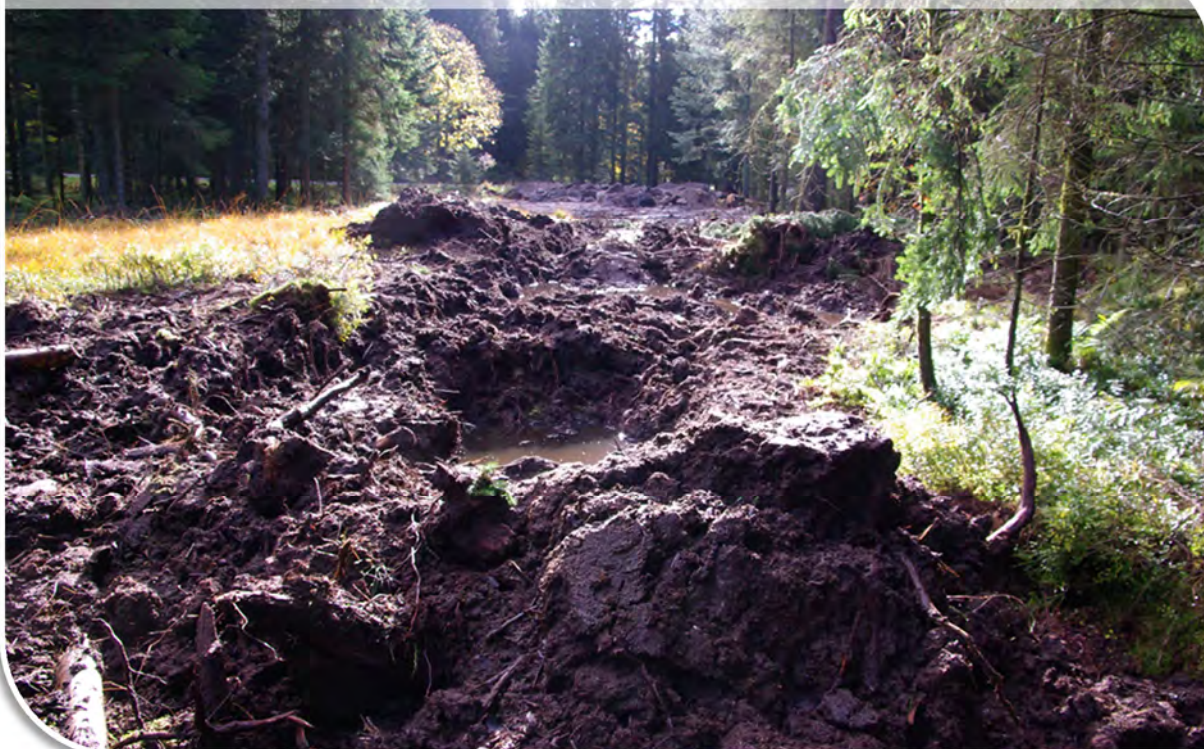
Travaux pour une piste de ski.
