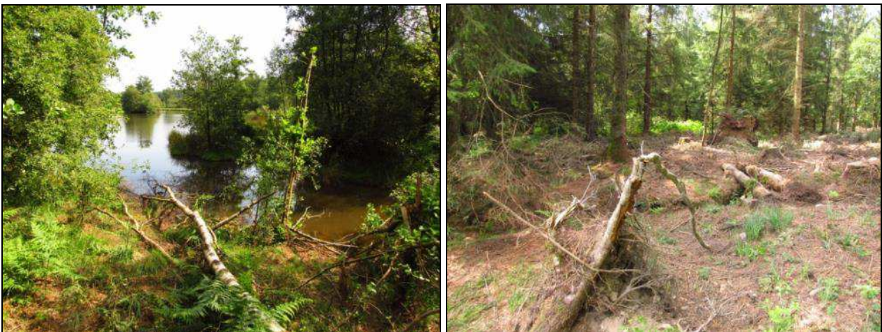
Vues de l'arrachage/de la coupe de feuillus en bordure de berge de l'anse semi-boisée au sud-ouest, et aussi d'une parcelle de conifères adjacente
